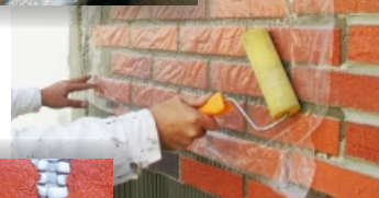
Špárovanie zavädnutého tmelu špárovačkou
