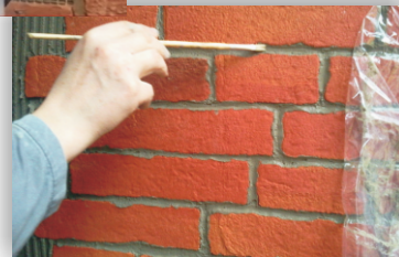
Došpárovanie a čistenie detailov
