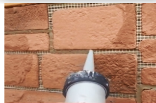
Došpárovanie a čistenie detailov
