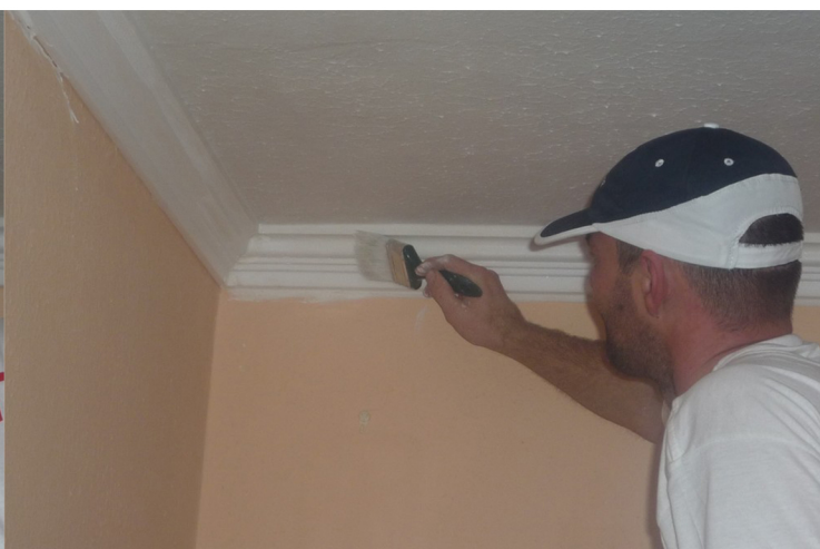
10. NAFARBÍME AKRYLÁTOVOU FARBOU
