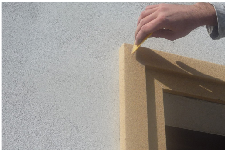
7. NA SPOJE NANÁŠAME RETUŠOVACÍ MATERIÁL
