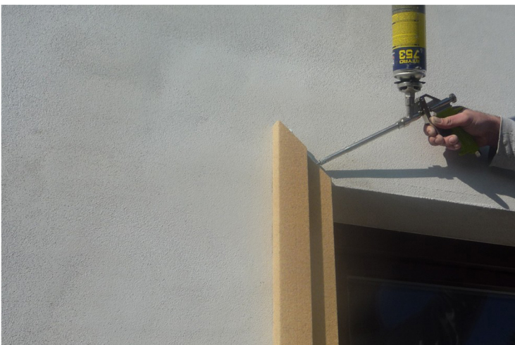
5. NA SPOJE POUŽÍVAME LEPIACU PU PENU
