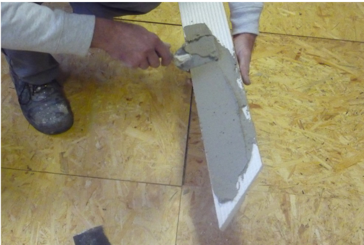
3. NA LIŠŤU NANÁŠAME FLEXIBILNÉ LEPIDLO
